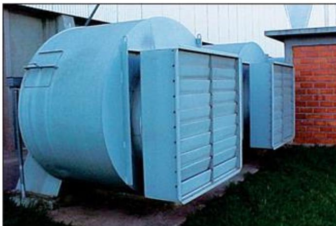
**Figura 10:** Ventilador ou exaustor
